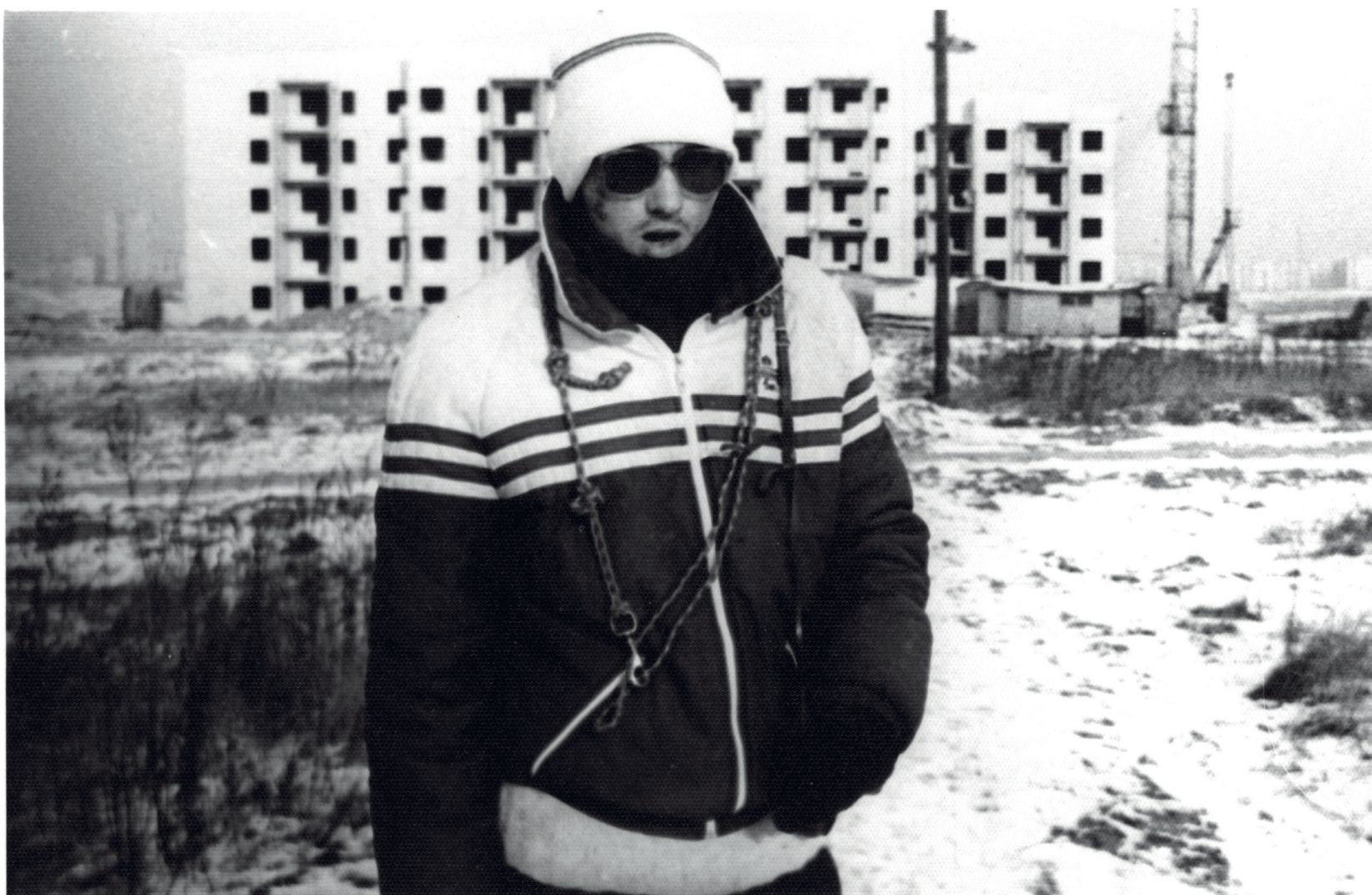
Stanisław Hać na tle budowanych bloków na Oruni Górnej, lata 90-te. Archiwum Ewy Hać.
