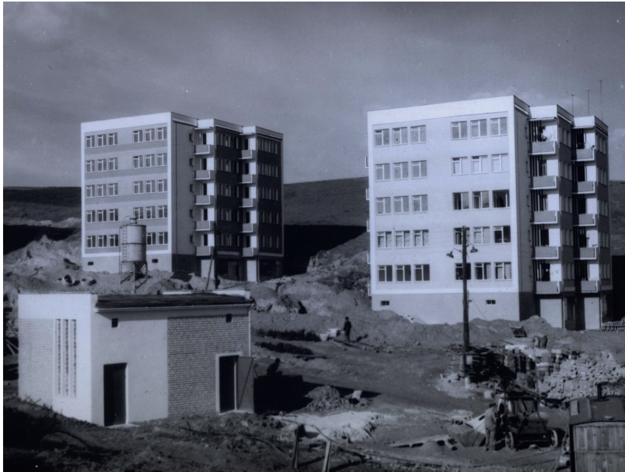
Budowa bloków przy ulicy Diamantowej, 1965 rok. Archiwum Gdańskiej Spółdzielni Mieszkaniowej
